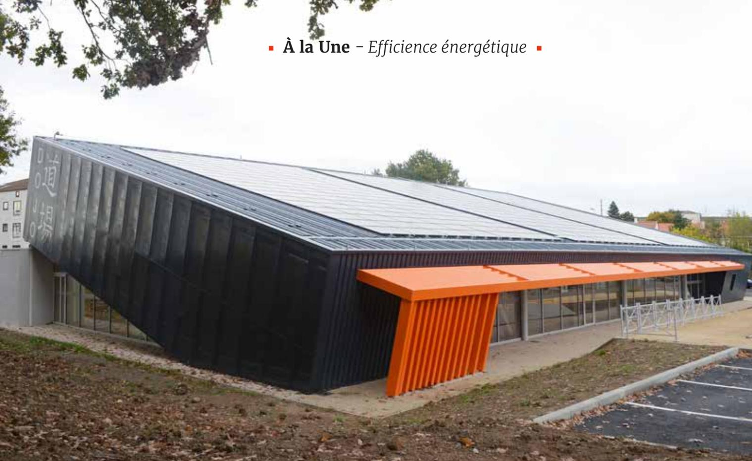
600 m<sup>2</sup> de panneaux photovoltaïques ont été installés en 2018 sur le toit de la salle des arts martiaux à La Roche-sur-Yon.
