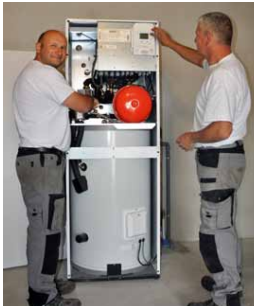
Les équipes de Systeo Énergies sur le terrain.
