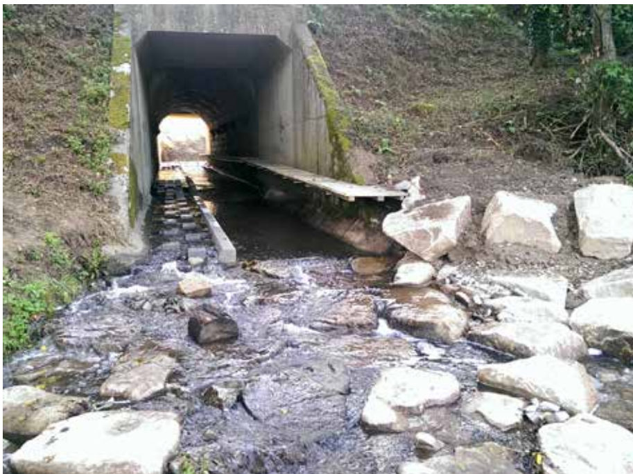
Passage à faune sous la rue Olof-Palme.
