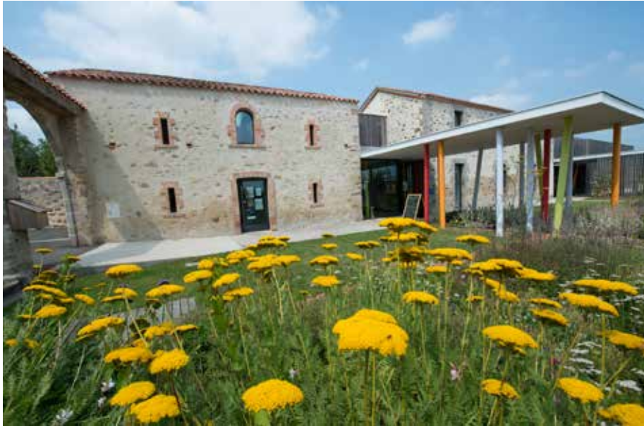
Des nichoirs sur la façade de la Maison des libellules.
