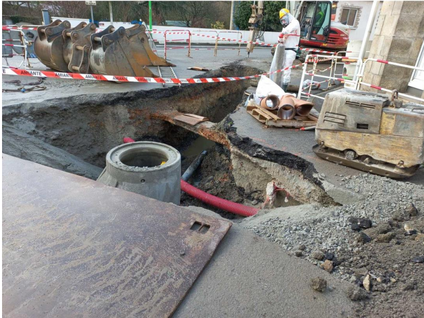
Travaux rue de Bellevue à Dompierre-sur-Yon
