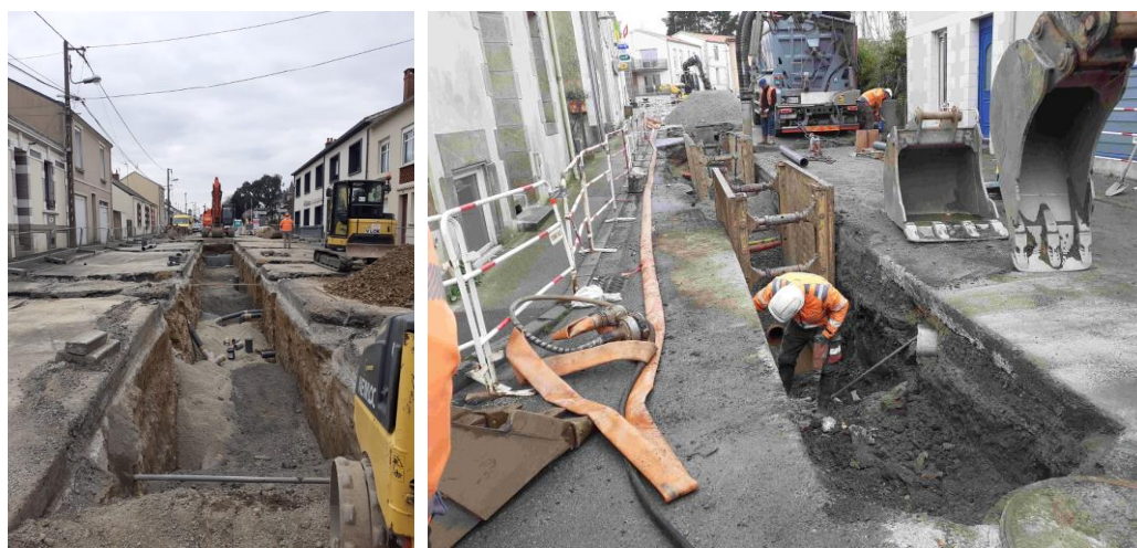
Renouvellement de réseaux d'assainissement des eaux usées
