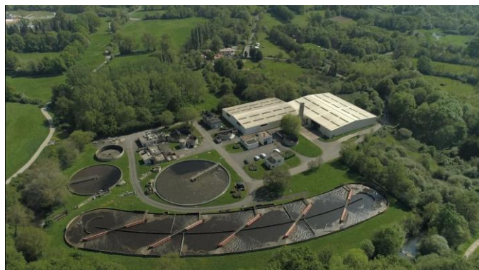
Station d'épuration de MOULIN GRIMAUD - La Roche-sur-Yon
