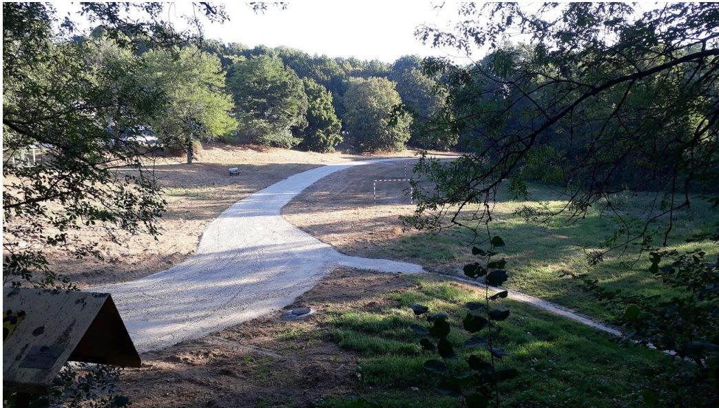
Restructuration des chemins d'exploitation du réseau EU DN 300 de la vallée de la Riallée en 2022
